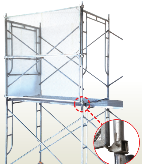
養生枠取付施工例
