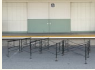
② ジャッキベースに合わせて梁とプレスを設置します。
