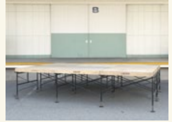
④ ジャッキベースで高さ(水平)を調節して完成です。
