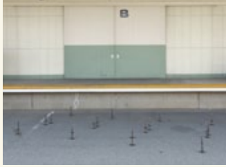
① ステージ設置位置に、ジャッキベースを配置します。
