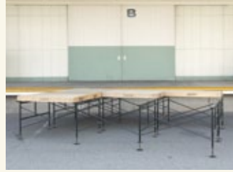
③ 梁の上に天板を設置します。
